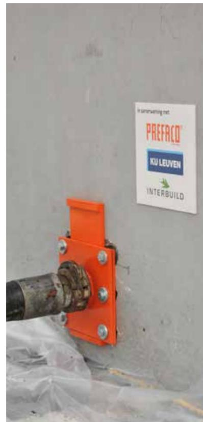
en hauteur, un raccord pompe en bas du mur est une solution ingénieuse. Ce raccord pompe comprend un clapet verrouillable qui peut être raccordé à une pompe à béton.
